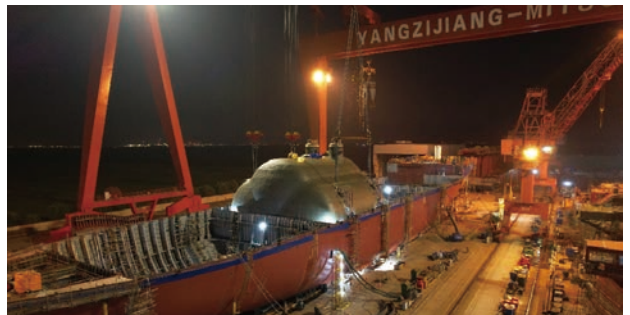
2023年6月15日 Jun. 15, 2023 首只 C 型罐搭载 Installation of 1st Type-C LPG Cargo Tank
